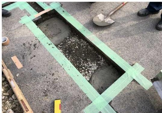
3-3 モルタルの上に i /lock を設置します。(予めカバーを外しておきます。)
