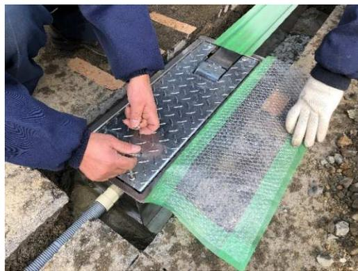
3-5 管用コネクターに埋設電線管を取り付けます。
