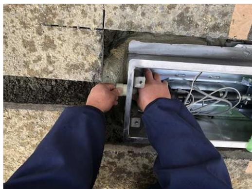
3-4 通線口に管用コネクターを取り付けます。(別紙標準設置図内配線経路図参照)
