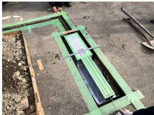
3-6 外していたカバーを取付、養生シートを元に戻します。
