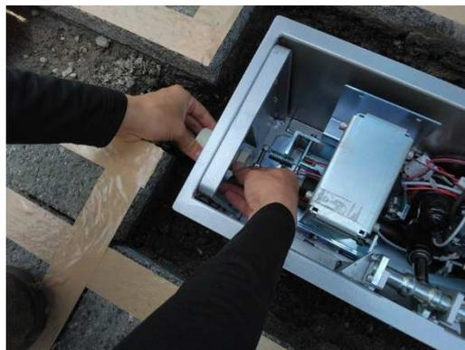
3-4 通線口に管用コネクターを取り付けます。(別紙標準設置図参照)
