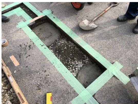
3-3 モルタルの上に i /lock を設置します。(予めカバーを外しておきます。)
